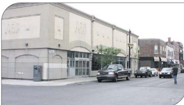
L'ancien supermarché IGA de la rue Notre-Dame, fermé depuis plus de deux ans, c'est 20 000 pieds carrés qui seront récupérés, réutilisés, recyclés et transformés en un grand centre multiservices, qui abritera sept organismes communautaires d'économie sociale de Lachine.
